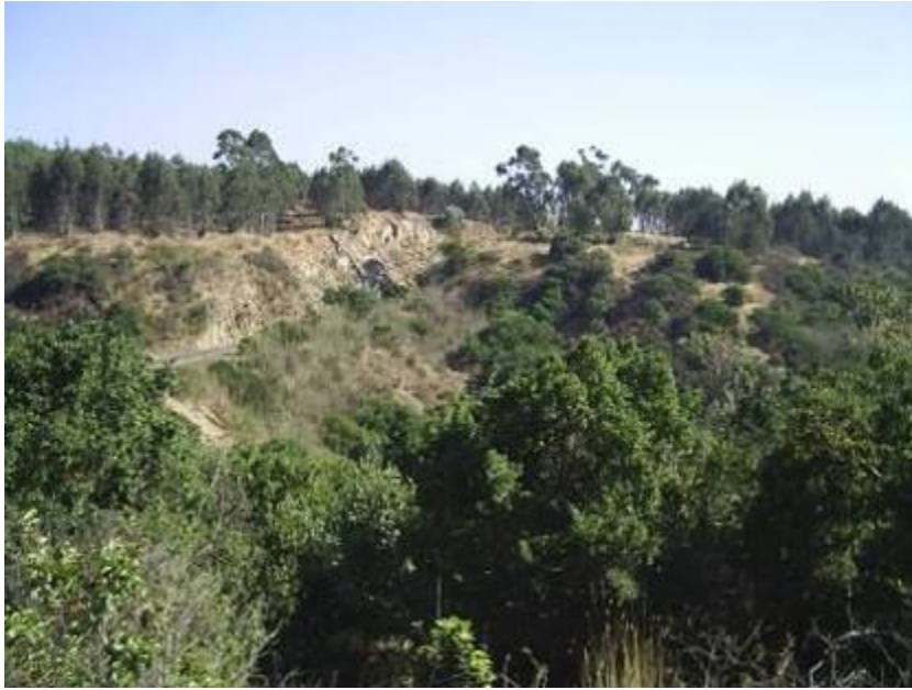
Fotografía N° 19 Trazado Línea Férrea
